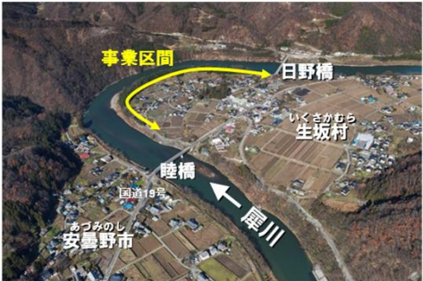
下生野地区堤防整備事業
