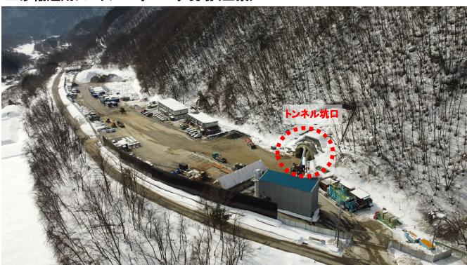
掘削状況 (NATM工法)
