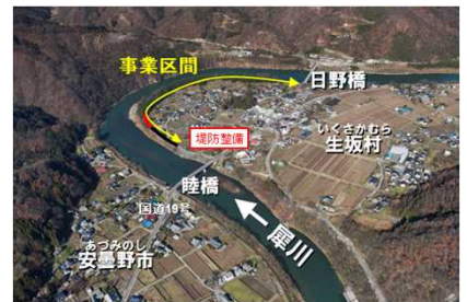
下生野地区堤防整備事業
