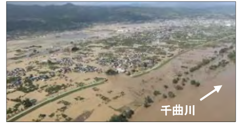
令和元年東日本台風(長野市穂保地先の被害状況)
