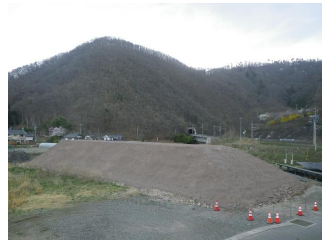
R7年度トンネル掘削ズリ搬出事例 （安曇野市産業団地造成）
