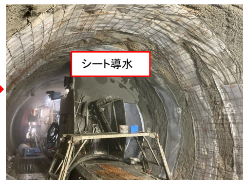
湧水箇所のシート導水
