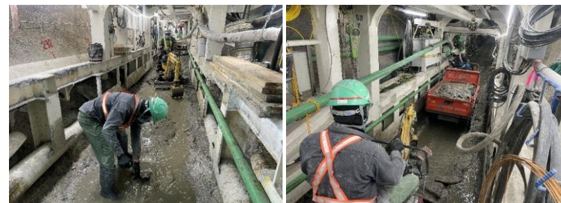
ミニBHと不整地運搬車による土砂撤去状況
