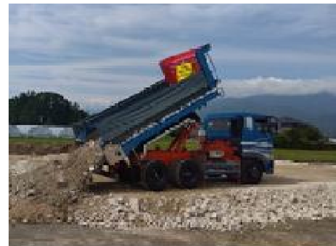
R7年度トンネル掘削ズリ搬出事例 （松川村宅地造成）
