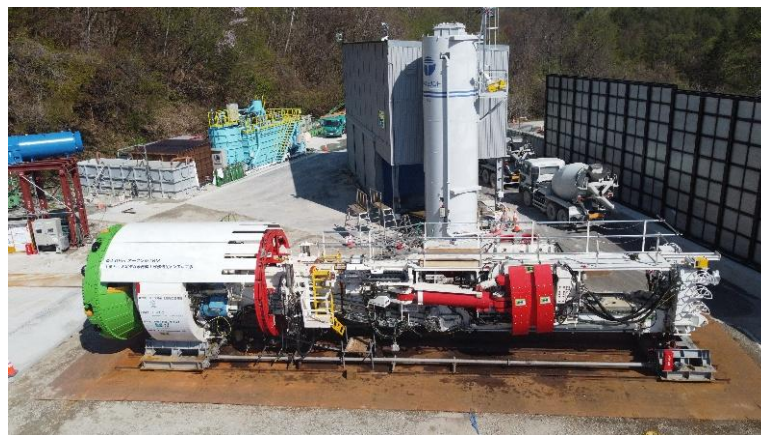
TBMマシン本体(令和7年4月)
