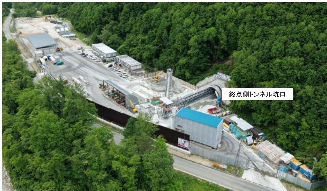
箆川作業ヤード(令和8年6月)
