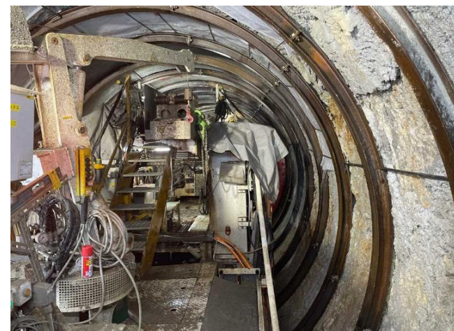
トンネル坑内施工状況(令和8年6月)
