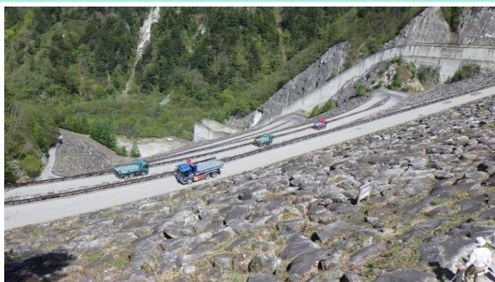
ダンプトラックによる運搬（高瀬ダム堤体道路）
