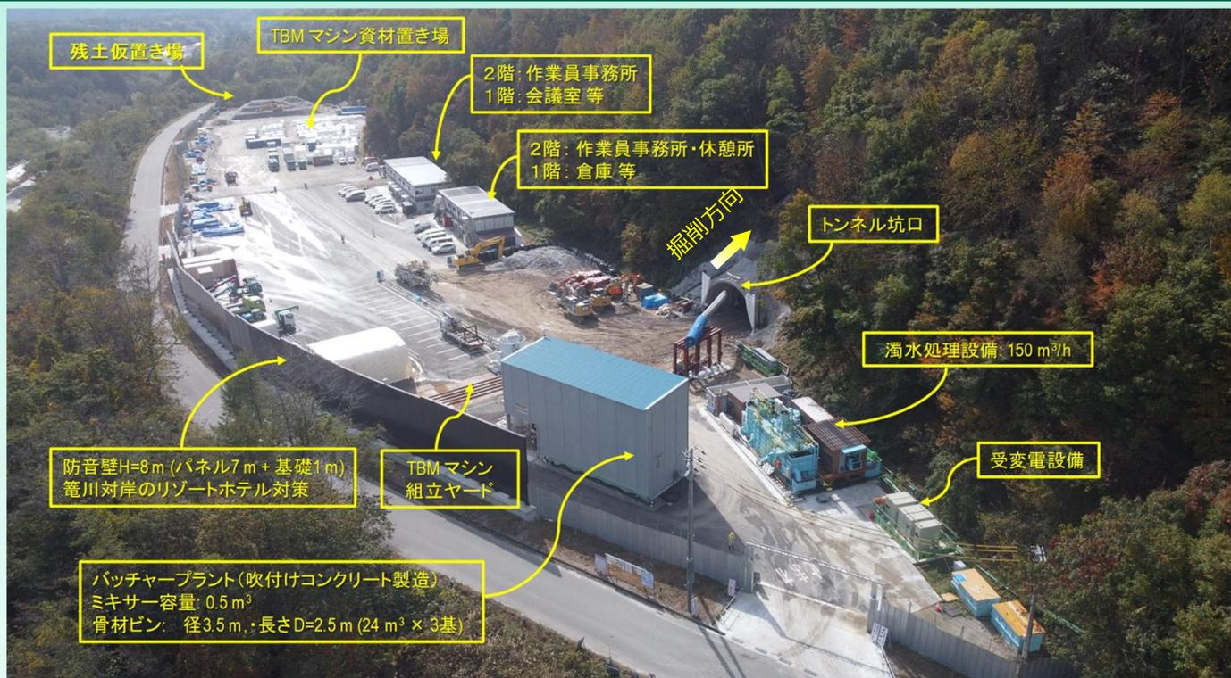
トンネル施工仮設備ヤード (2024 (令和6) 年10月時点)
