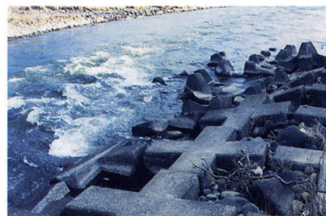
十字コンクリートブロック根固め
