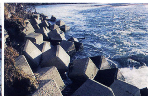
大脚コンクリートブロック根固め
