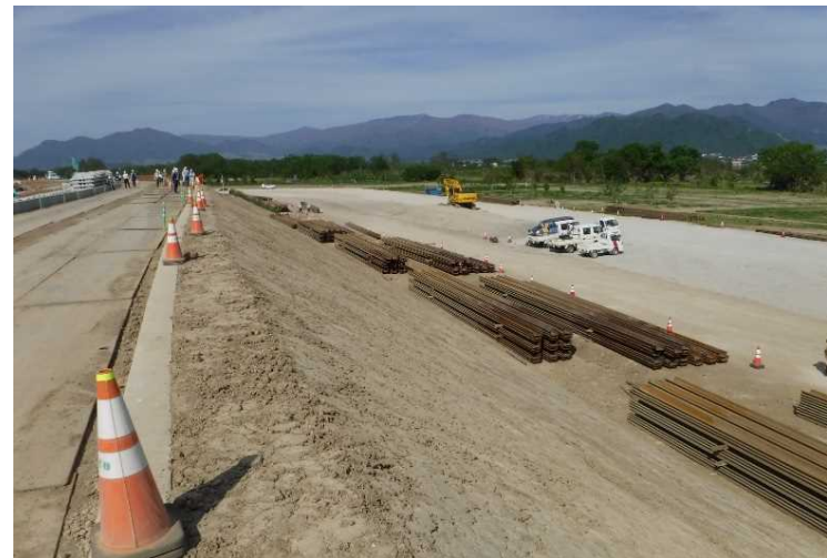
工事の施工状況
