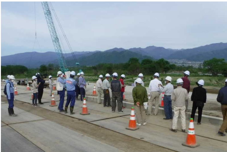
堤防天端にて施工状況の説明
