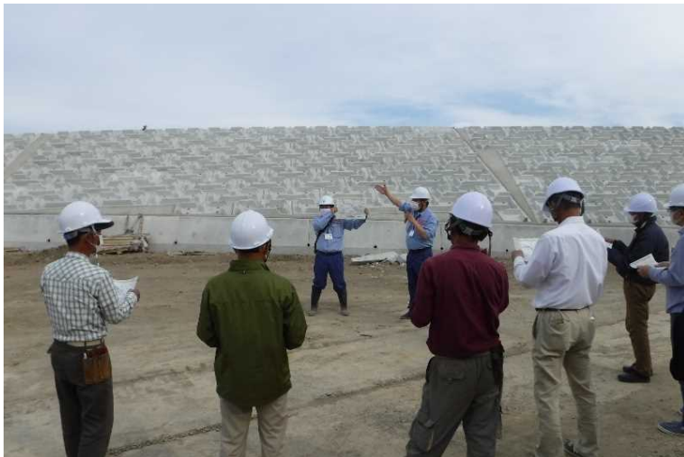
工事概要の説明
