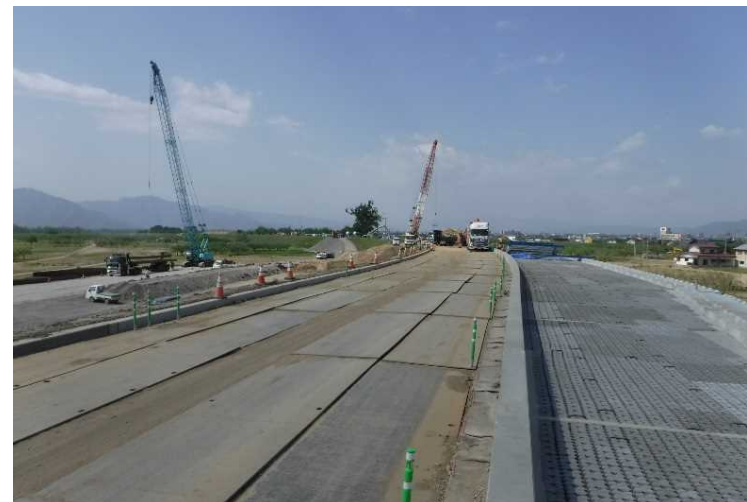
工事の施工状況
