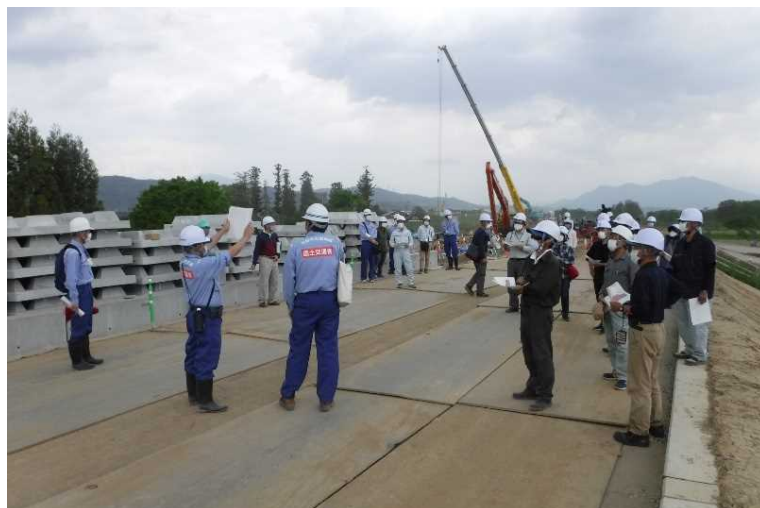
堤防天端にて施工状況の説明
