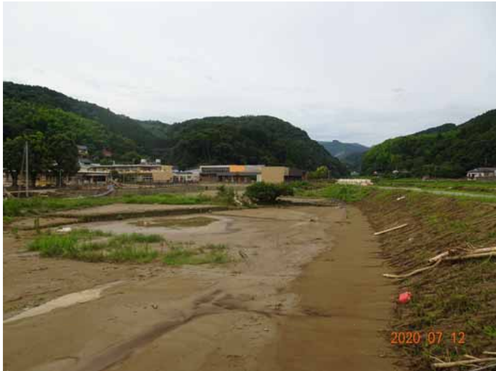
小川下流からの見る千寿園
