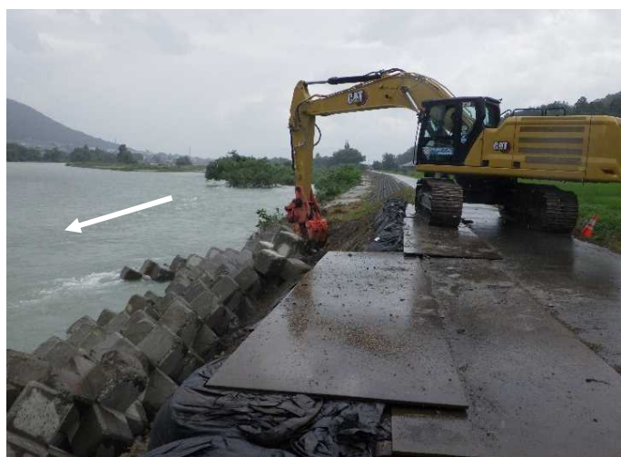
被災箇所 応急復旧工事中 (R6.7.9撮影)
