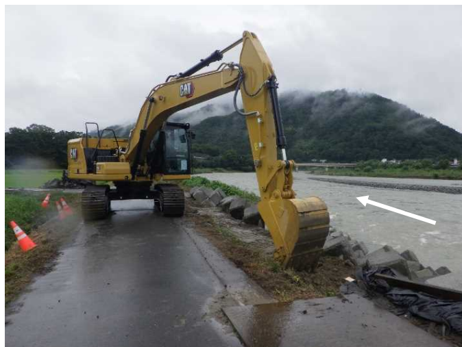
被災箇所 応急復旧工事中 (R6.7.11撮影)
