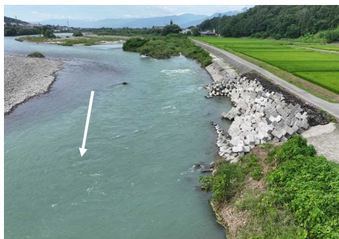
応急復旧作業完了後(R6.7.26撮影)
