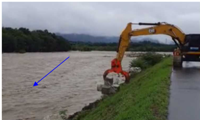
応急復旧作業状況
