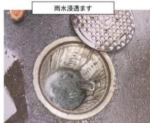
〈個人・事業所等が設置する雨水の貯留浸透施設〉
