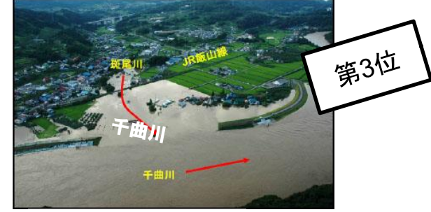
中野市替佐地区の浸水被害状況
