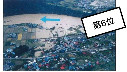
中野市替佐地区の浸水被害状況
