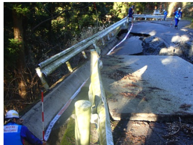
道路崩壊箇所を調査
