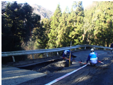
路面陥没箇所を調査
