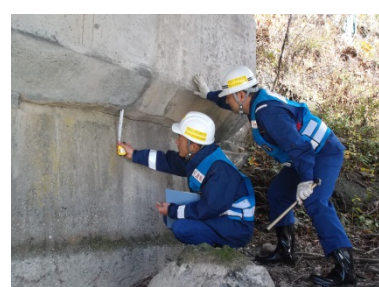
橋台のクラック調査
