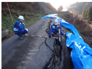
道路亀裂箇所を調査
