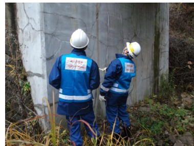
橋台のクラック調査
