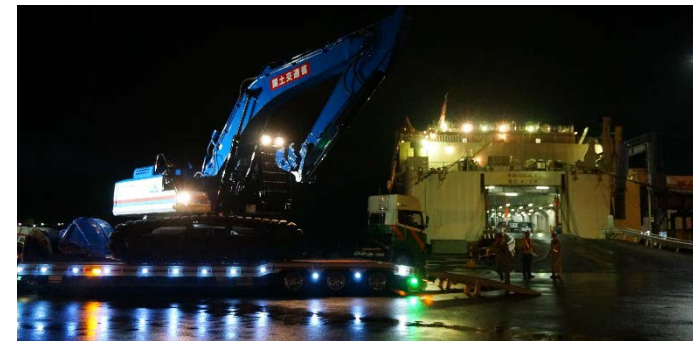
▲バックホウ及び照明車フェリー乗船（7日撮影）
