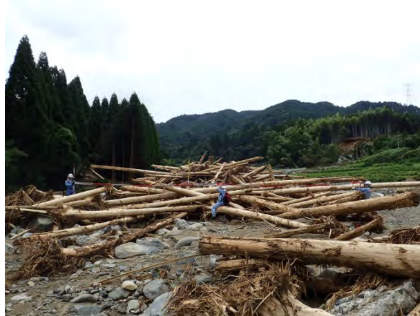
▲7月18日 朝倉市黒川流域 流木調査 【砂防第1班】
