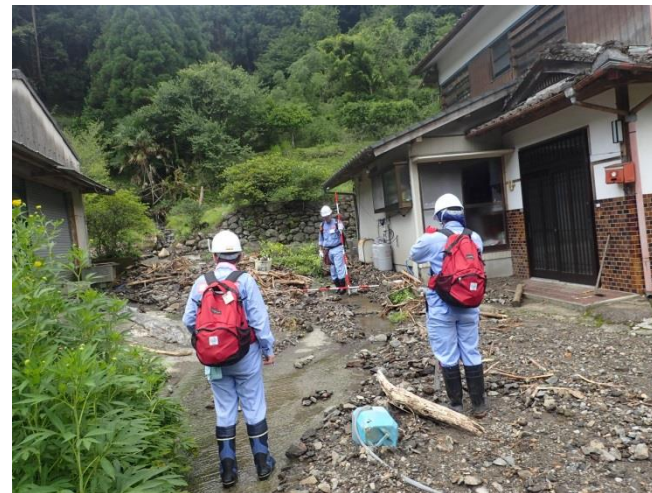
▲7月14日 朝倉市疣目川流域 砂防緊急箇所点検 【砂防第2班】
