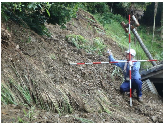
▲7月14日 朝倉市疣川流域 砂防緊急箇所点検 【砂防第1班】
