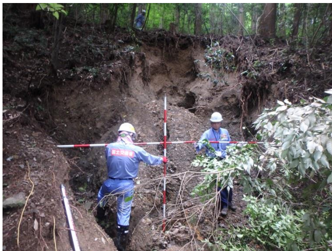
▲7月14日 朝倉市疣目川流域 砂防緊急箇所点検 【砂防第1班】
