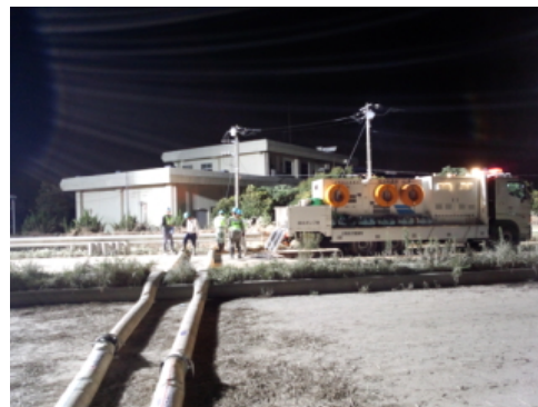
常総市相野谷町相野谷浄水場の湛水・排水状況
