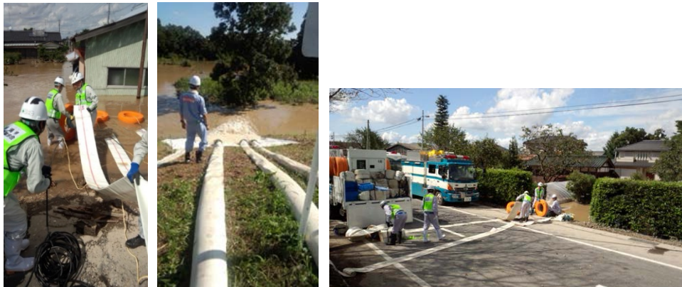
常総市新井木町大和橋付近
