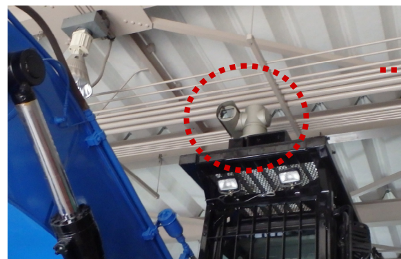
カメラ取付状況
