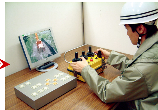
操縦室での状況
