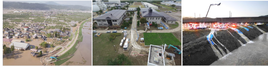
令和元年東日本台風
