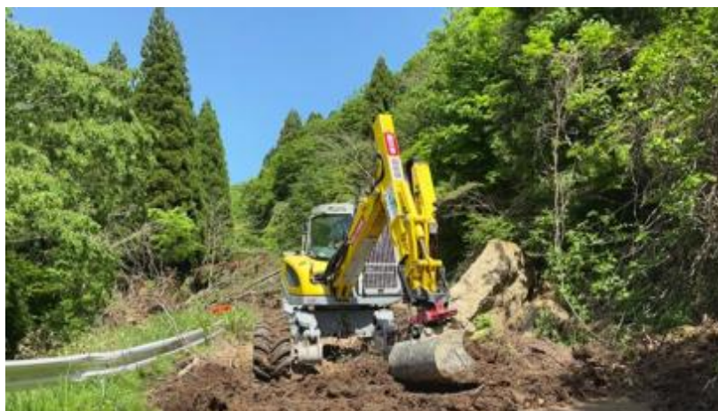
バケットによる掘削作業
