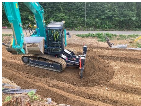
①ICT敷き均し
