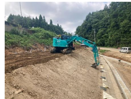
③法肩ICT締め固め転圧管理
