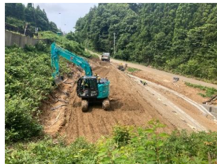
②ICT締め固め転圧管理
