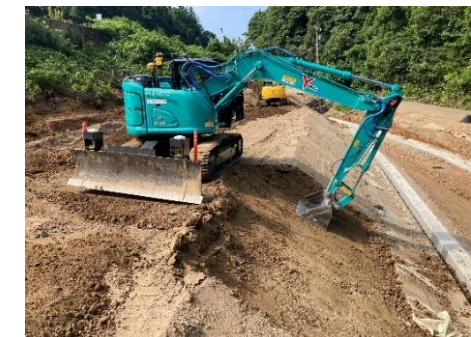
④ICT法面整形
