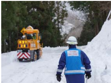
(主) 韮崎増富線 除雪作業状況 (H26.2.17)
