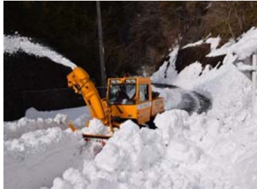
国道139号 除雪作業状況 (H26.2.20)
