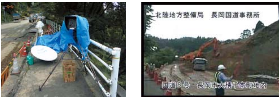
写真7-4-6 Ku-SATの設置・運用状況(左)、配信映像(右)
