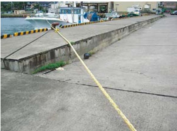
写真3-14-7 中央埠頭物揚場エプロン陥没状況
