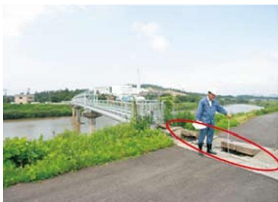
写真3-6-1 水道管周辺の堤体の沈下状況
