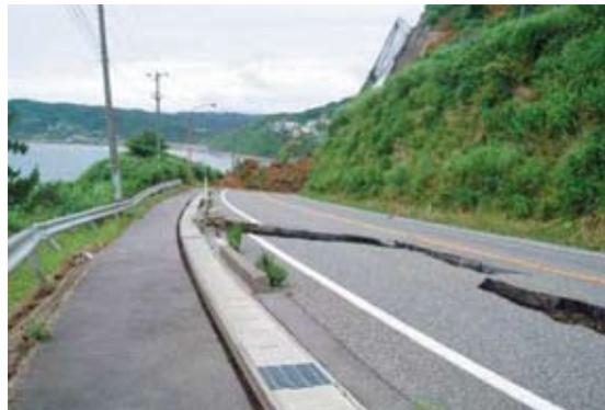
写真3-8-5 陥没した路面
