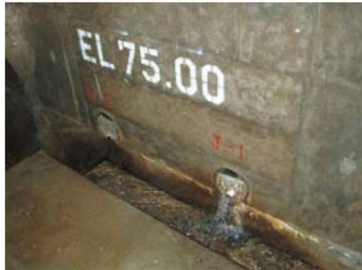
写真3-5-3 正善寺ダム調査状況及び漏水状況
