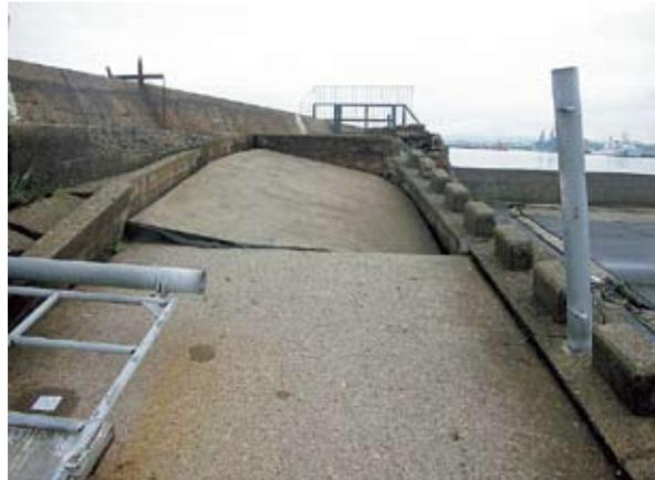
写真3-14-6 西埠頭 西防波堤陥没状況
