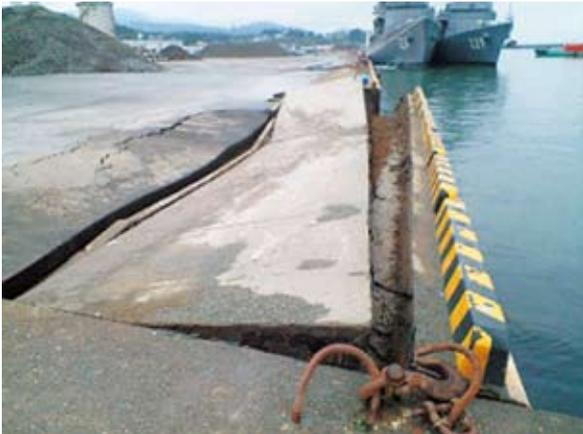
写真3-14-5 中浜埠頭3号岸壁東側端部 取付護岸前倒状況
