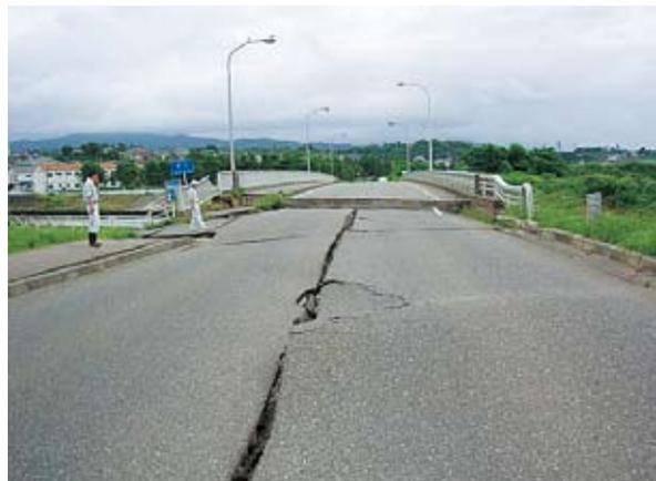
写真3-14-8 臨港八坂橋橋梁取付部段差発生状況
