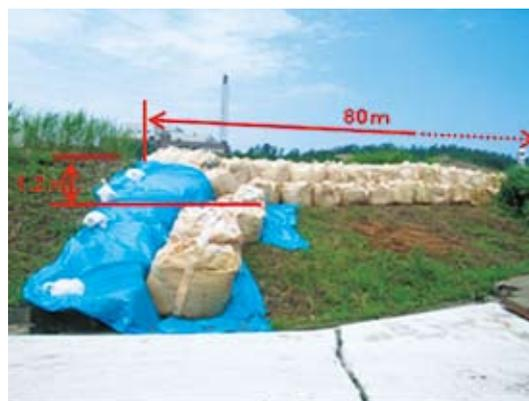
写真3-6-2 堤防沈下箇所に於ける応急復旧
