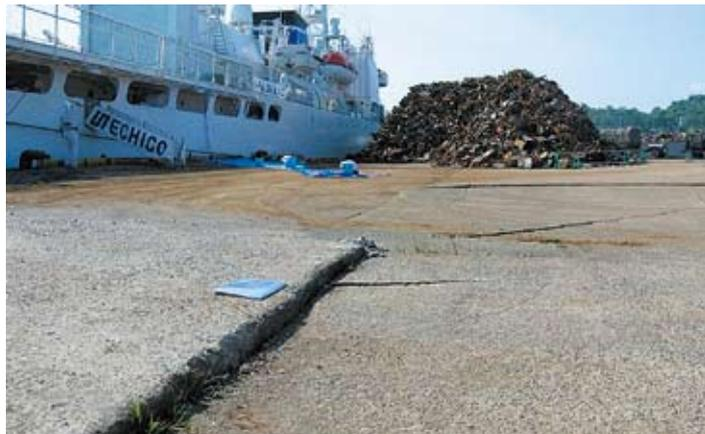
写真3-14-10 東埠頭岸壁エプロン部陥没状況
