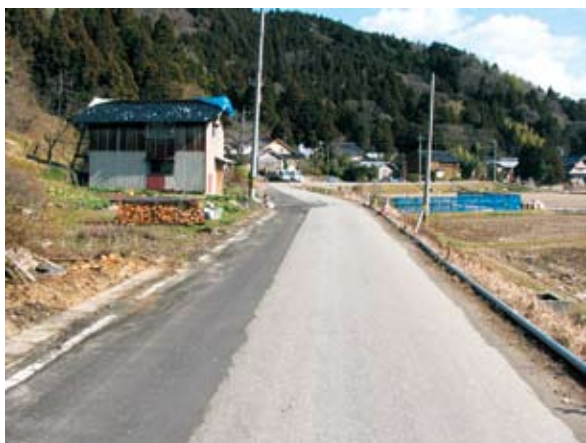
写真4-2-4 輪島市田村地区 (管渠敷設完了(仮舗装済み))
