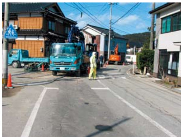
写真4-2-5 輪島市深田地区 (管渠敷設工事中)
