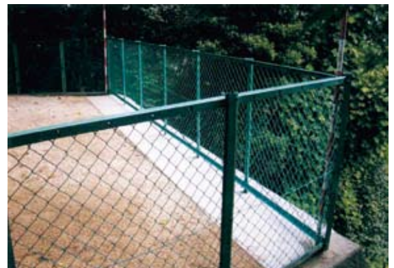
写真4-2-2 フェンスの復旧状況
