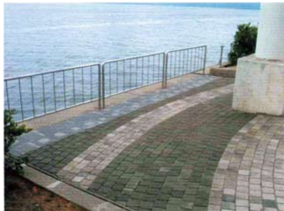
写真4-2-3 インターロッキングブロックの復旧状況
