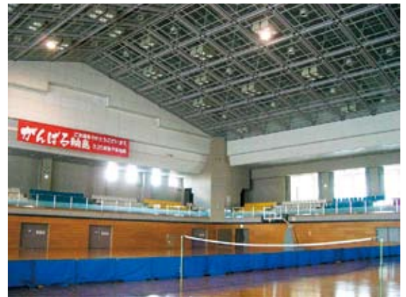
写真4-2-1 体育館の復旧状況
