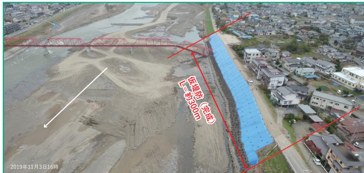
急流河川で水当たりが強く、施工が困難極めたので、瀬替工を実施して水当たりを弱めた上で復旧工事。
