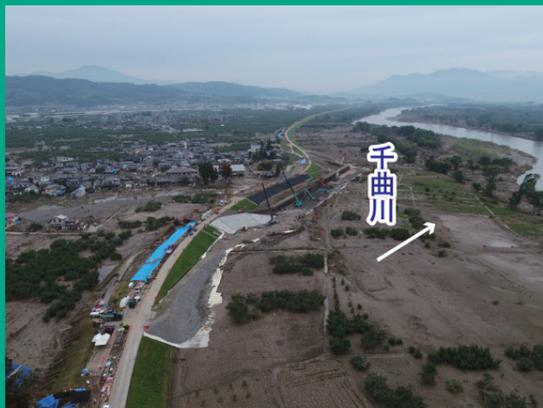
千曲川の堤防決壊箇所の緊急復旧（長野市穂保地区）
