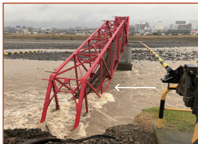
上田電鉄別所線の落橋（上田市諏訪形地区）
