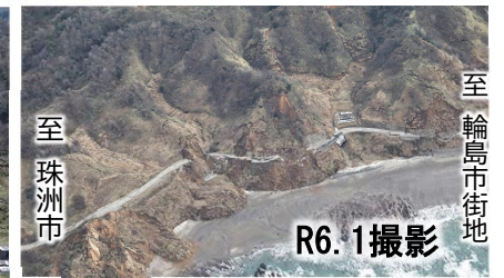
地震による地すべり・斜面崩壊
