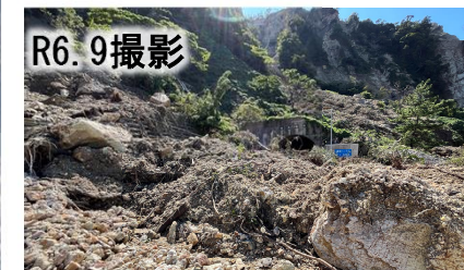
大雨による地すべり・斜面崩落
