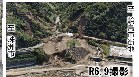
大雨による地すべり
