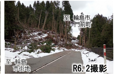
地震による斜面崩落
