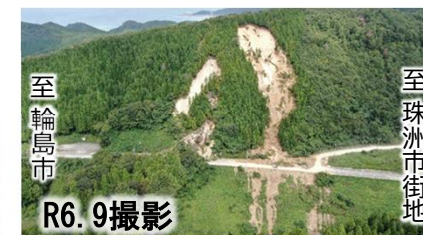
大雨による斜面崩落
