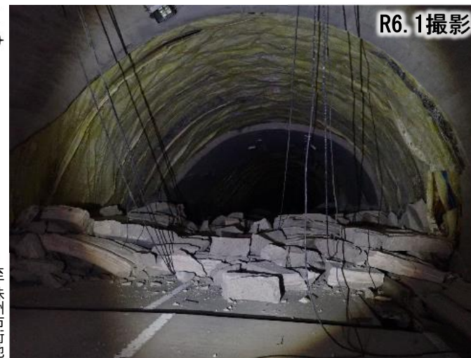
地震によるトンネル覆工崩落
