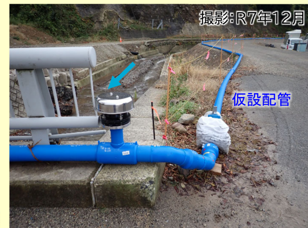
工事用道路が造成されたことで 上水道の仮設配管工事が完了 31
