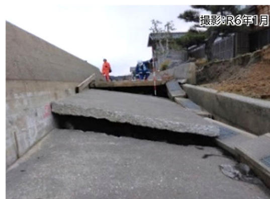
護岸・水叩き損傷
