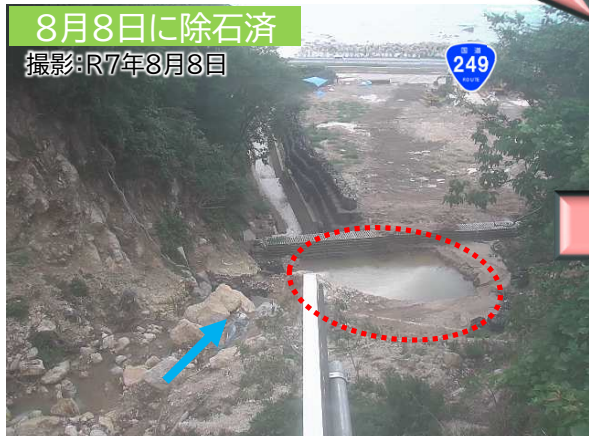
8月10日の出水で再度、土砂捕捉
