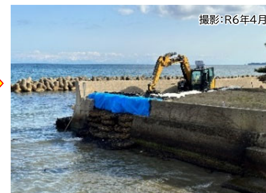
袋詰玉石、大型土のう敷設完了
