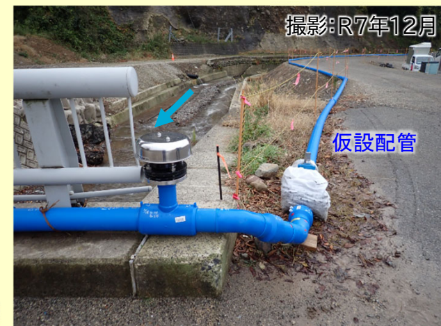
工事用道路が造成されたことで 上水道の仮設配管工事が完了
