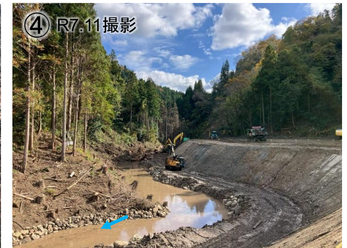
湛水池埋立 整備状況
