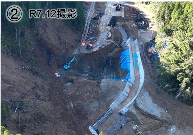
堰堤(最下流) 基礎掘削状況
