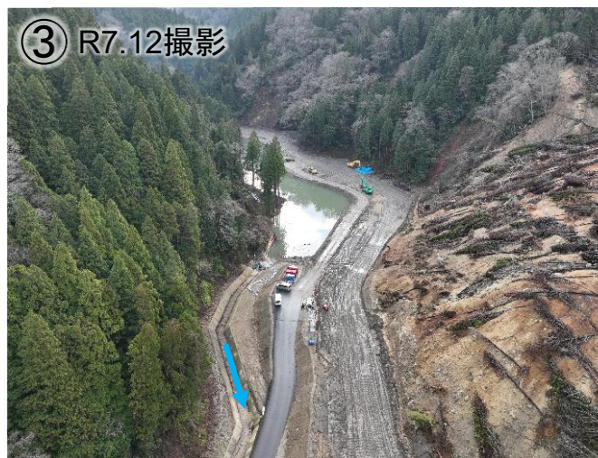
仮排水路復旧状況、二次仮排水路設置状況
