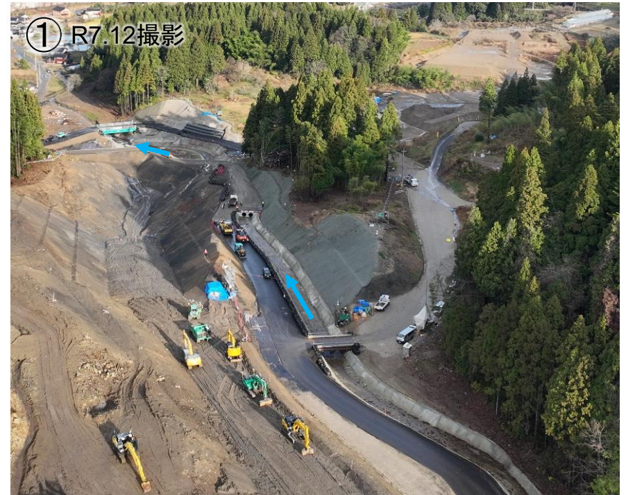
二次仮排水路設置 施工状況
