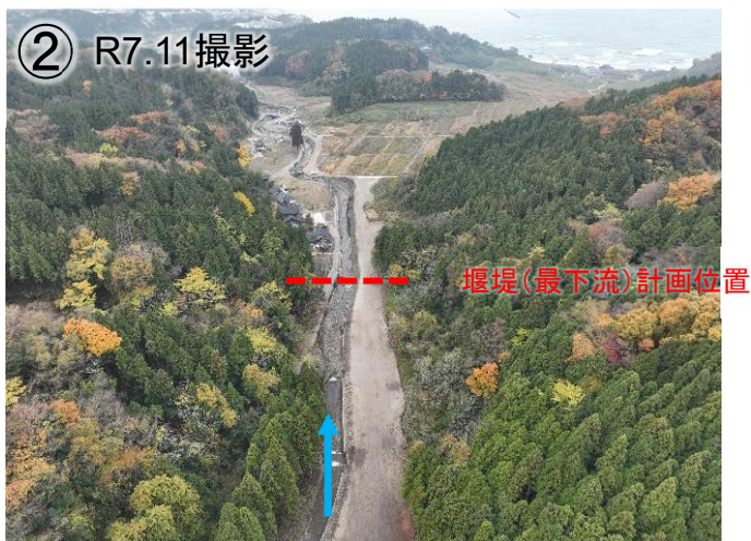
下流状況 (最下流堰堤 計画位置)
