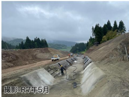
仮排水路工の施工状況
