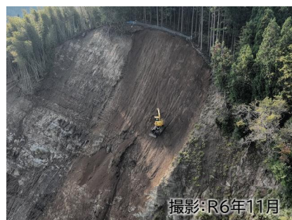
不安定土砂の撤去状況
