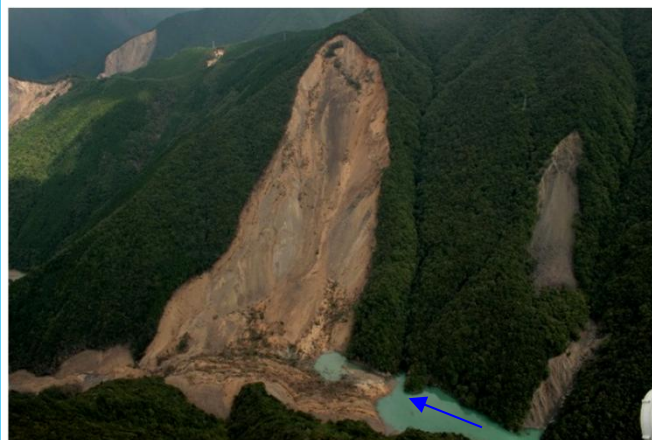
H23年台風12号による 紀伊山系 赤谷地区の被災事例
