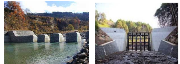
透過型砂防堰堤の事例(左写真:コンクリート透過型、右写真:鋼製透過型)
