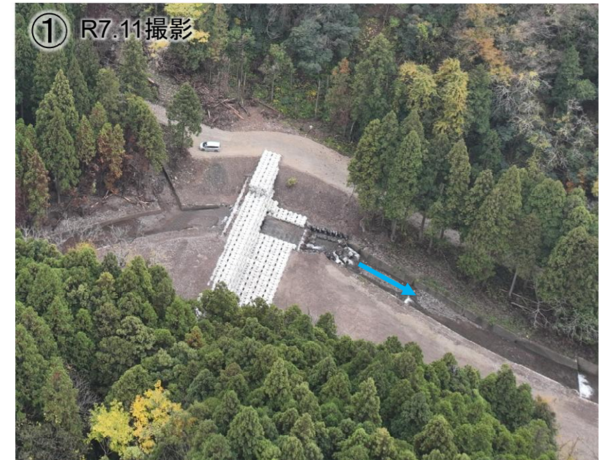
仮設堰堤 設置状況
