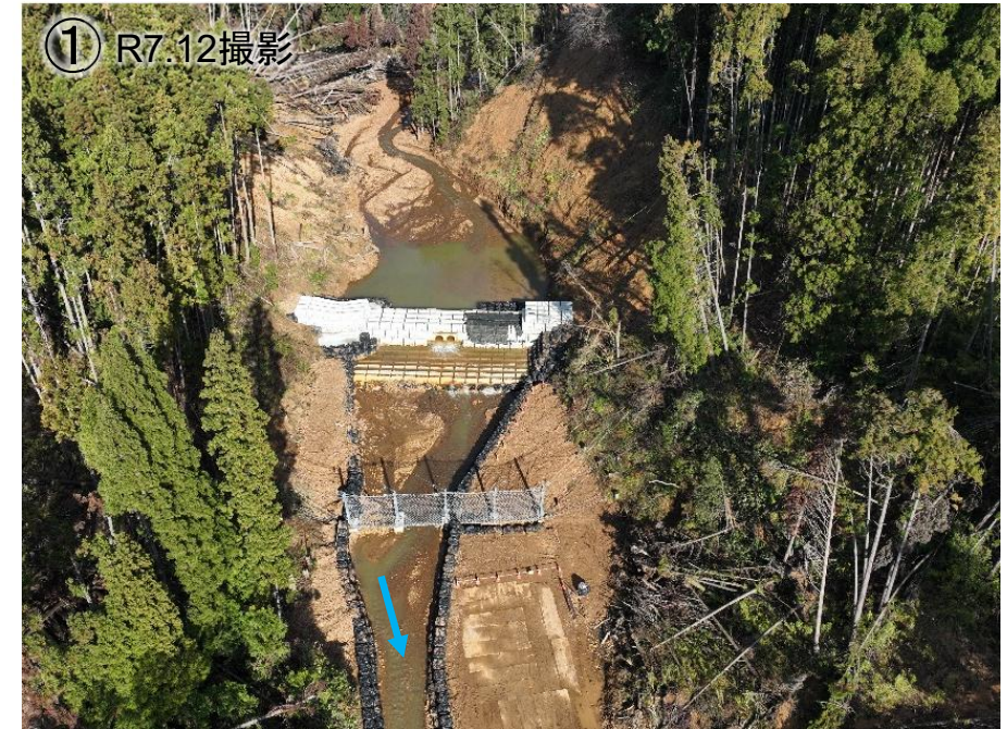
仮設堰堤・ワイヤーネット設置状況
