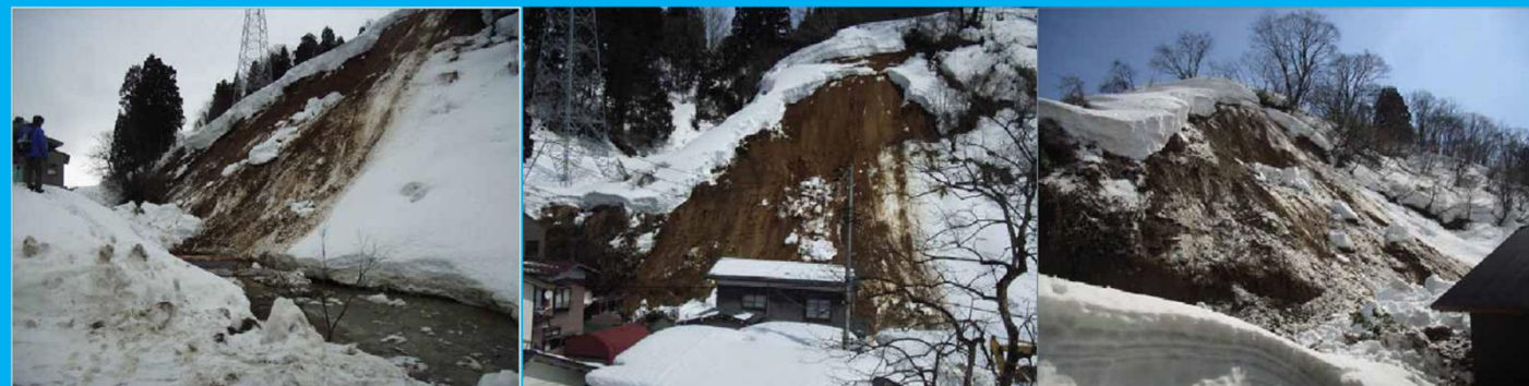
雪や土砂の崩れにより災害につながった事例
