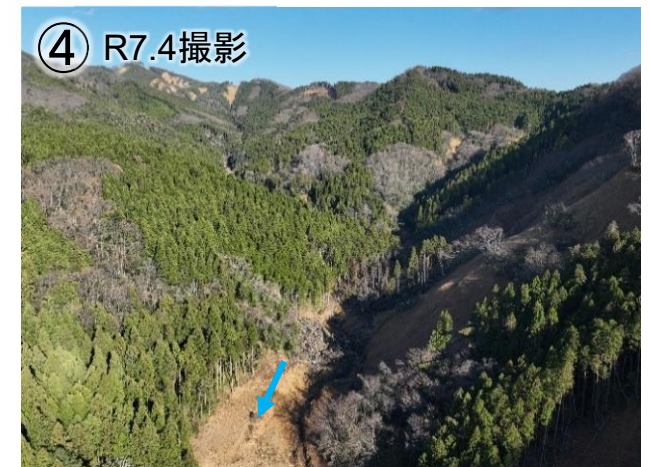
寺地川上流域の状況
