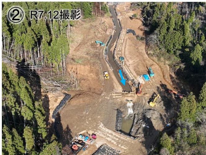
工事用道路施工状況
