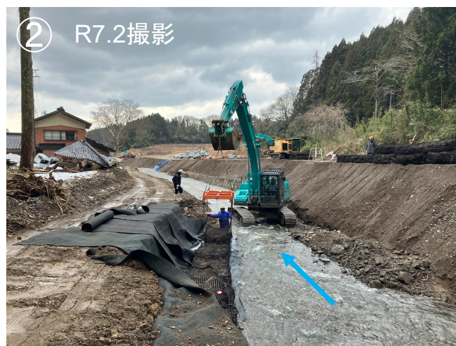
繊維かごマット設置状況
