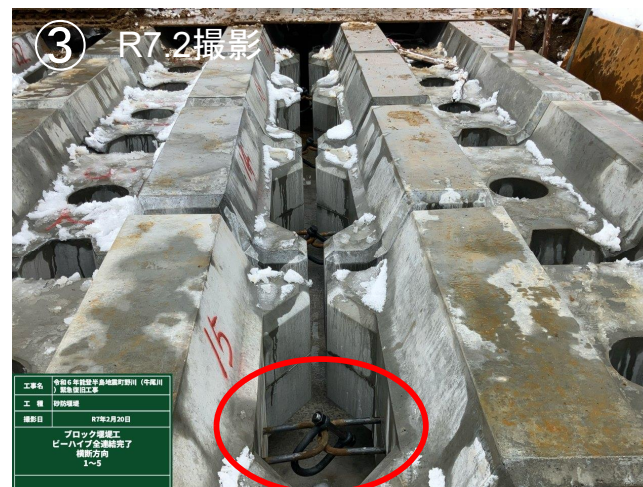
仮設堰堤 ブロック連結状況
