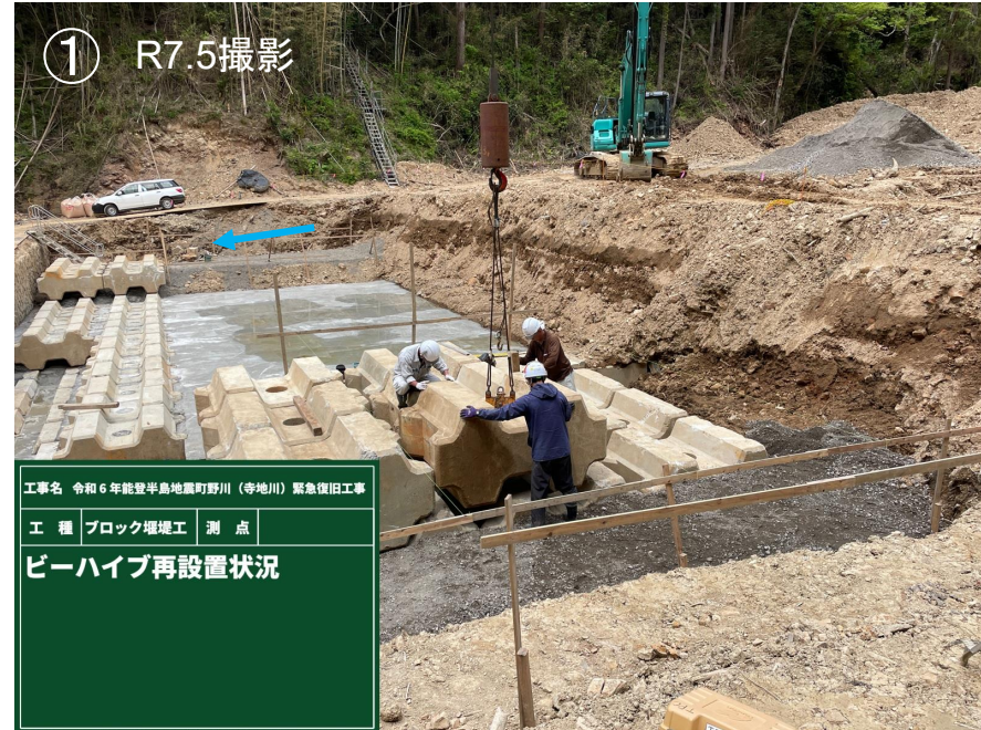
ブロック設置状況
