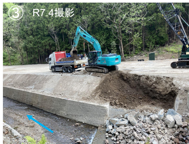
仮設堰堤箇所 掘削・土砂搬出状況
