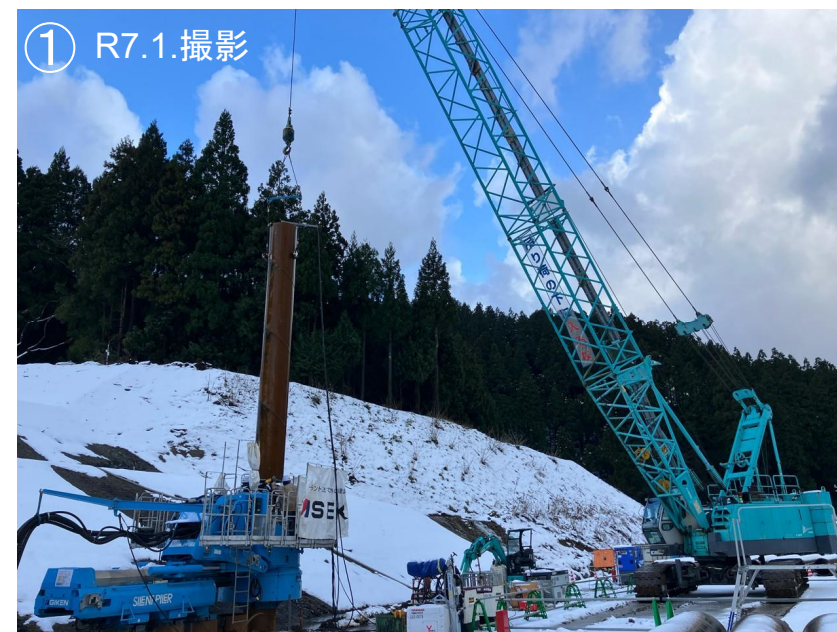
法止工(鋼管杭) 施工状況(R7.2.完了)
