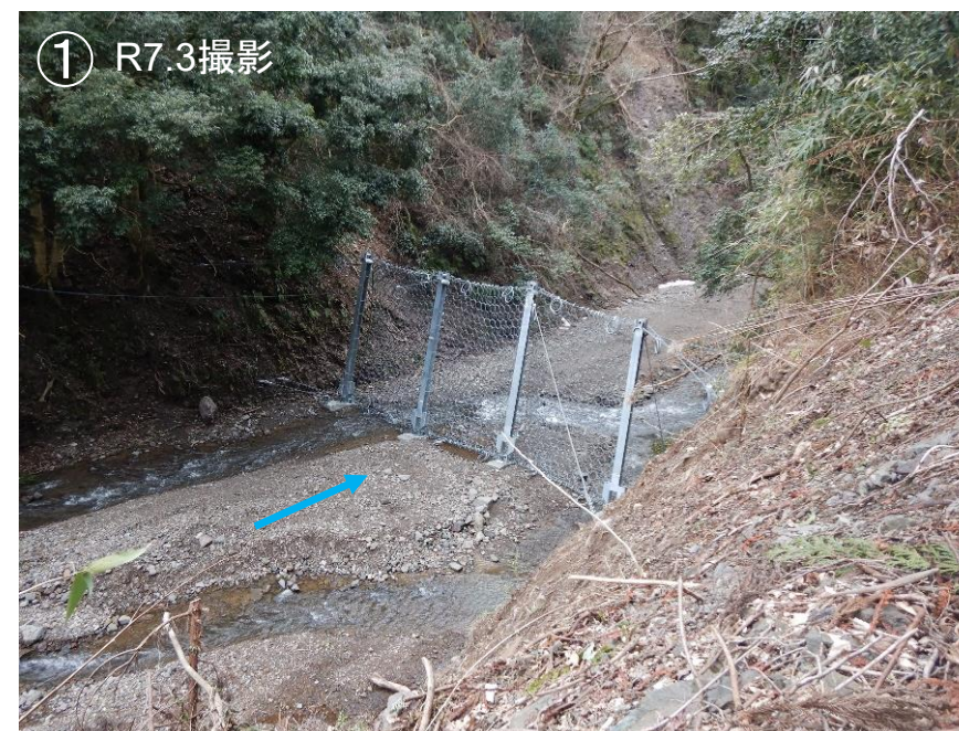
ワイヤーネット設置状況(R7.2完成)
