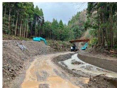
工事用道路の整備状況
