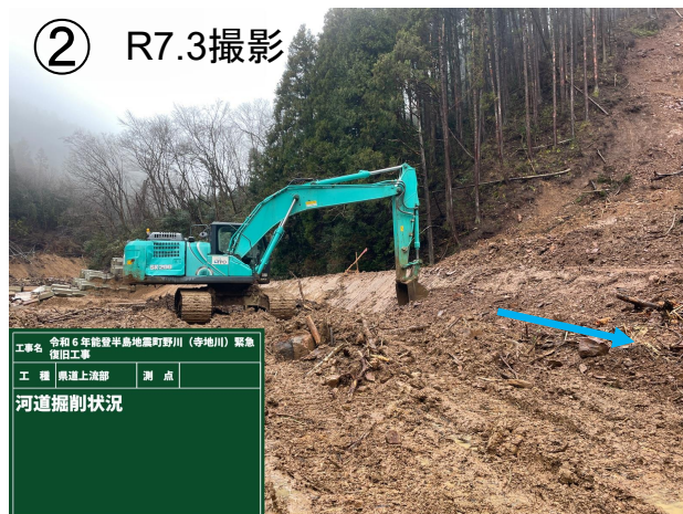
河道掘削状況
