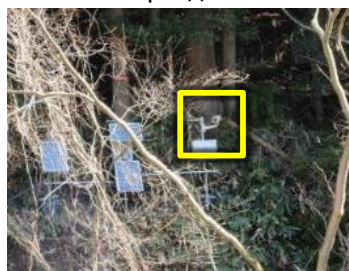
監視カメラ (紅葉川：市ノ瀬地区)
