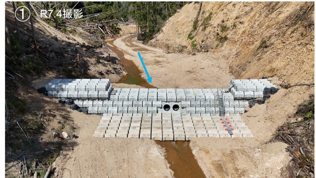
仮設堰堤設置状況(R7.4完成)
