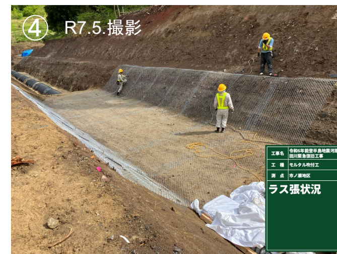
二次仮排水路 ラス張状況
