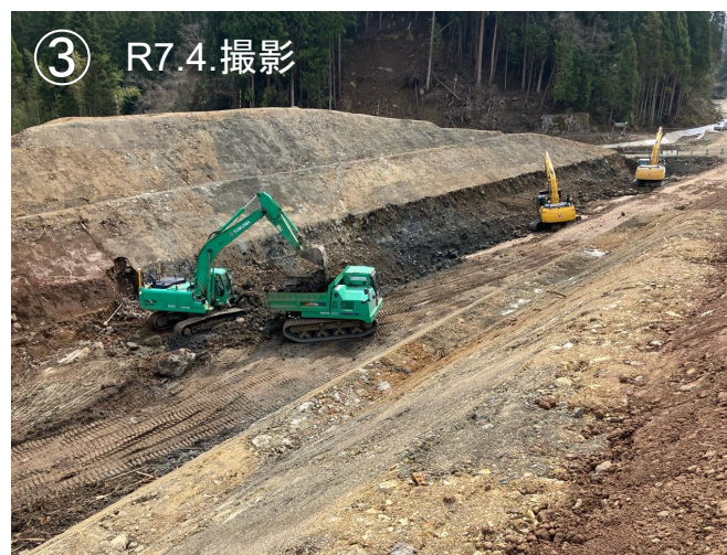
二次仮排水路箇所 掘削状況
