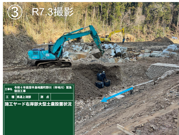
施工ヤード右岸部大型土のう設置状況
