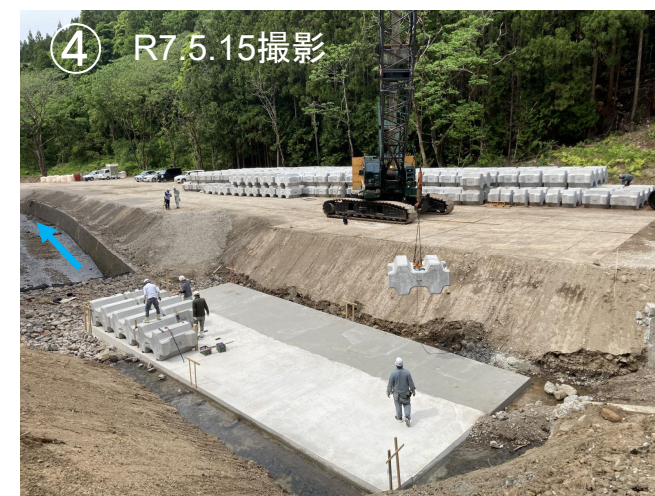
仮設堰堤設置状況
