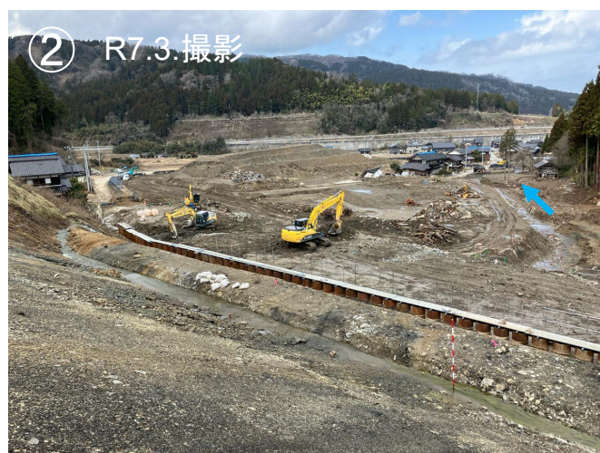
市道掘削状況
