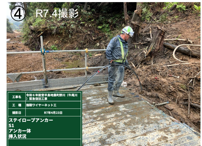
ワイヤーネット設置状況 (アンカー挿入状況)
