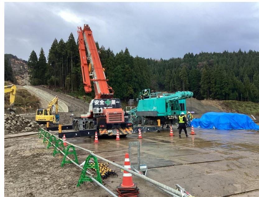
法止め工準備(クローラークレーン組立状況)
