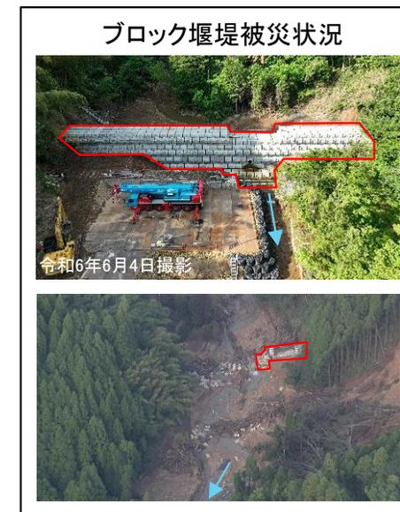
寺地川谷出口の状況 ブロック堰堤が一部流出し、河道内に大量の土砂・流木が堆積
