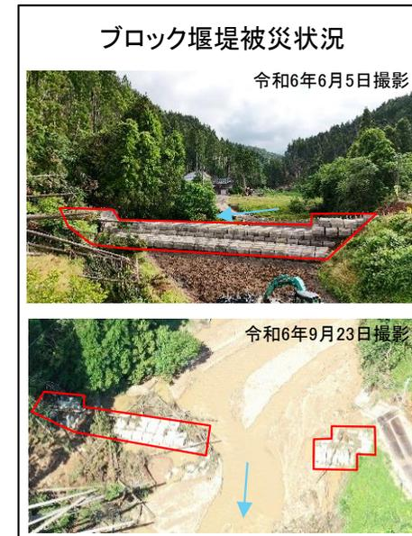
牛尾川谷出口の状況 ブロック堰堤が一部流失し、河道内に大量の土砂・流木が堆積
