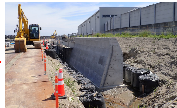
本復旧状況（直立堤施工）（R7.5）
