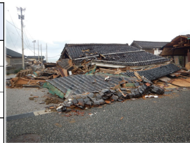
〔建物の倒壊(輪島市)〕
