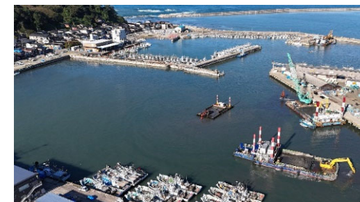
漁船だまり浚渫状況 (令和6年10月21日)
