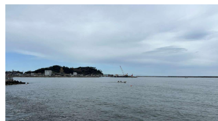
緊急浚渫完了 (R7. 4. 10浚渫完了)
