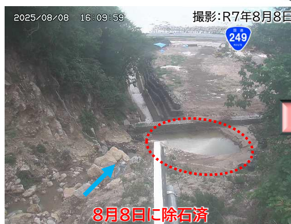
土砂流出防止工による土砂捕捉の状況
