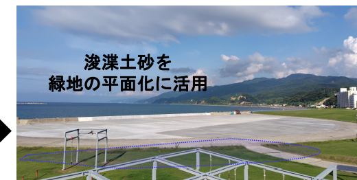
連携により土砂を有効活用
