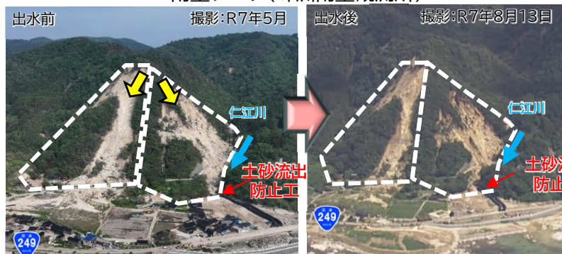
地すべりブロック全景:変状無し
