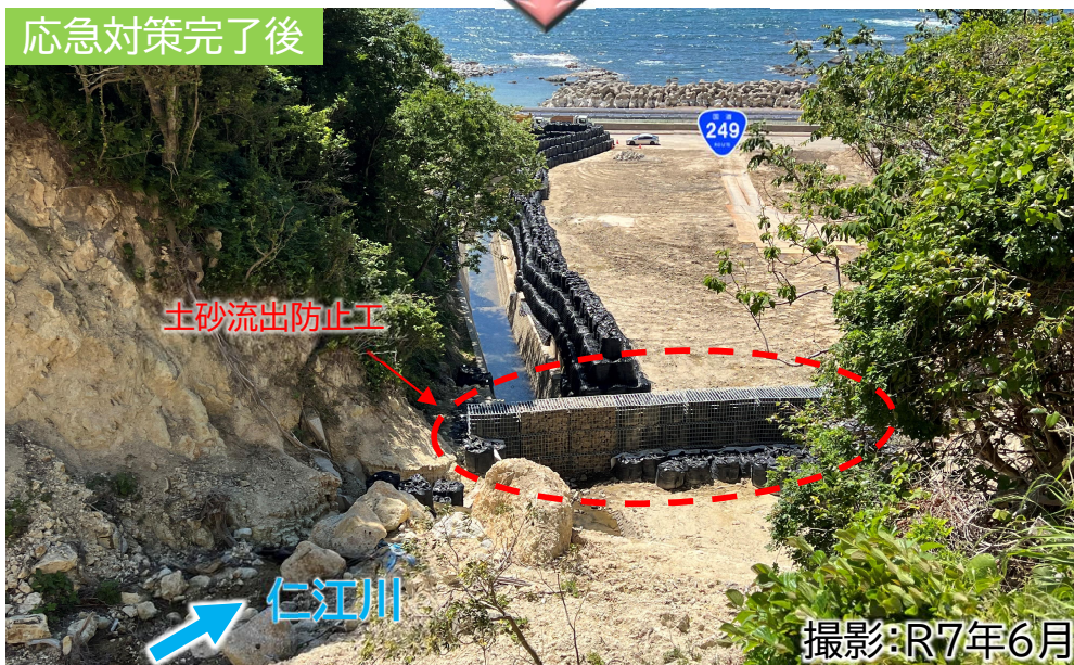
仮設護岸工の整備状況
