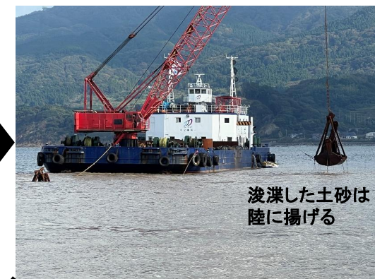
浚渫開始 (土砂を除去 (R6. 10. 28開始))
