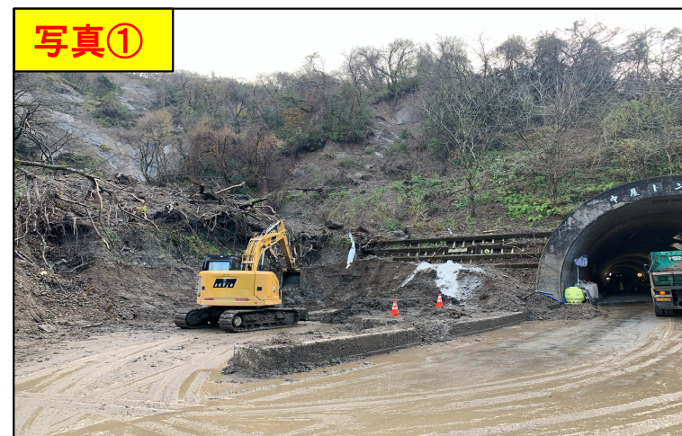
中屋トンネル(輪島市街地側坑口)の土砂撤去状況(R6.12)
