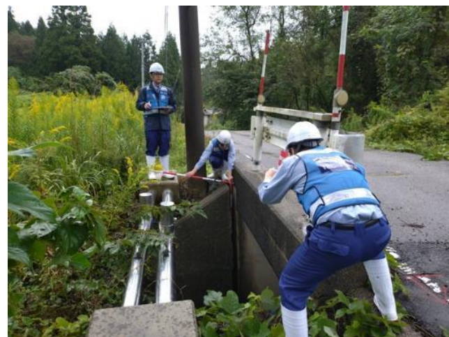
被災状況調査(珠洲市)
