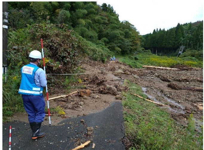
被災状況調査 (輪島市)
