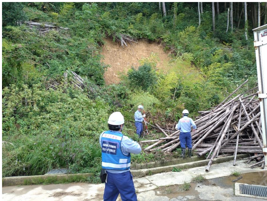
被災状況調査(珠洲市上戸町)
