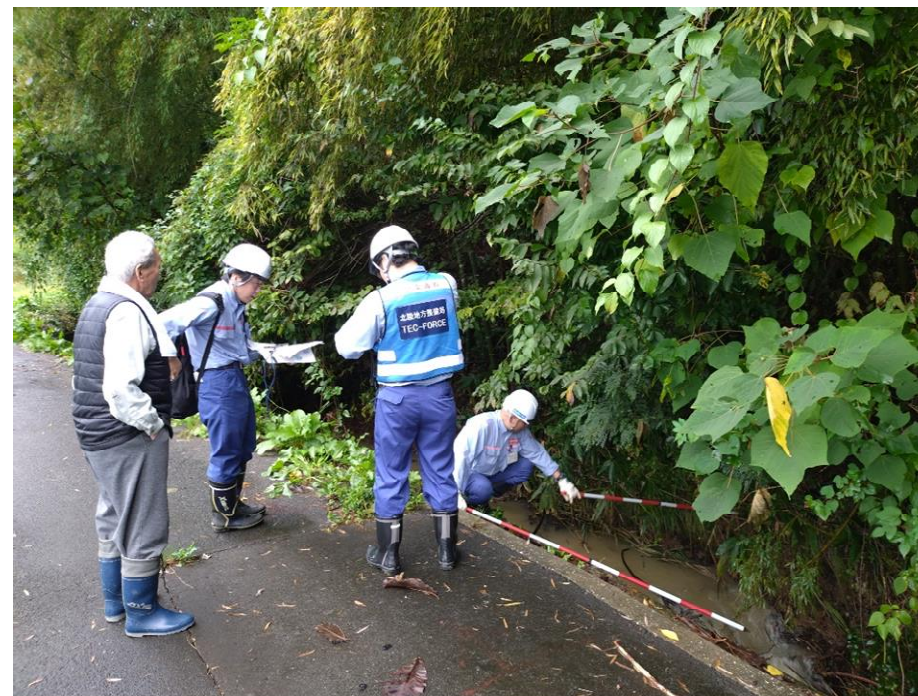
被災状況調査(珠洲市三崎町)
