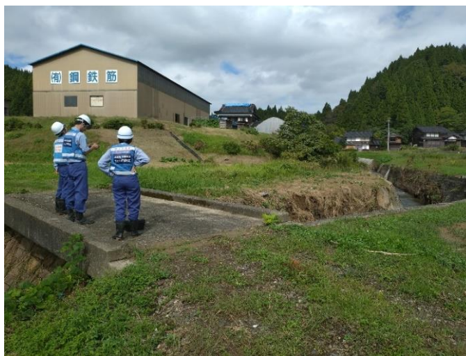
UAVによる被災状況調査(能登町)
