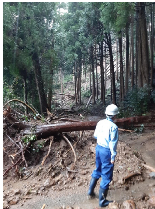
被災状況調査 (輪島市)
