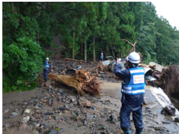
被災状況調査 (谷内河原川)
