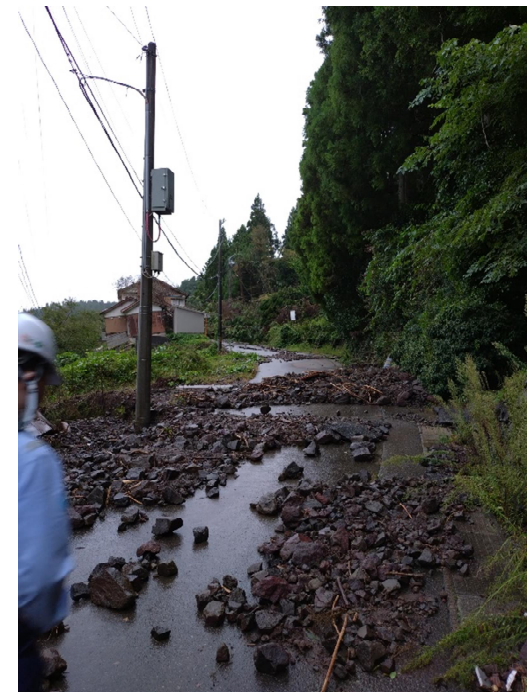
被災状況調査 (輪島市)
