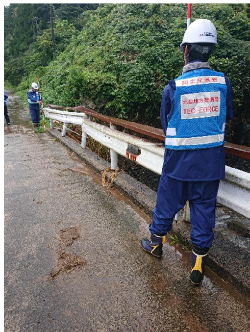
被災状況調査（輪島市）
