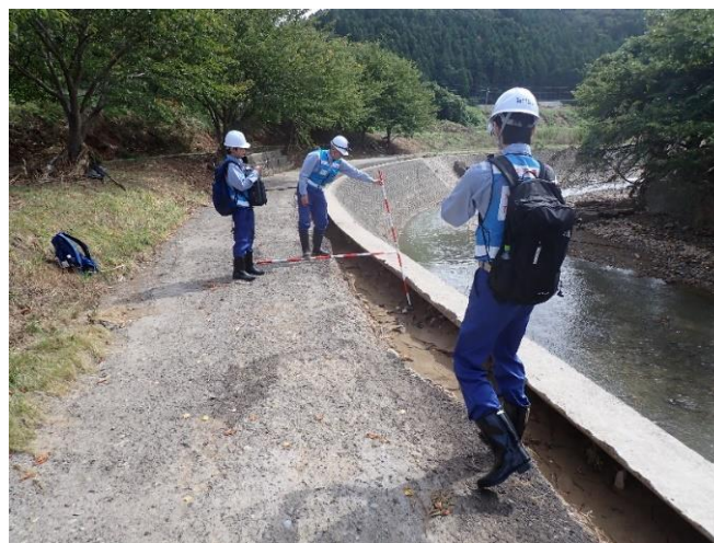
被災状況調査(南志見川)
