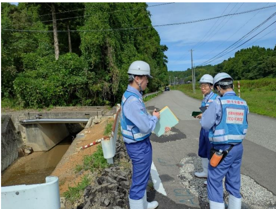
被災状況調査(珠洲市)
