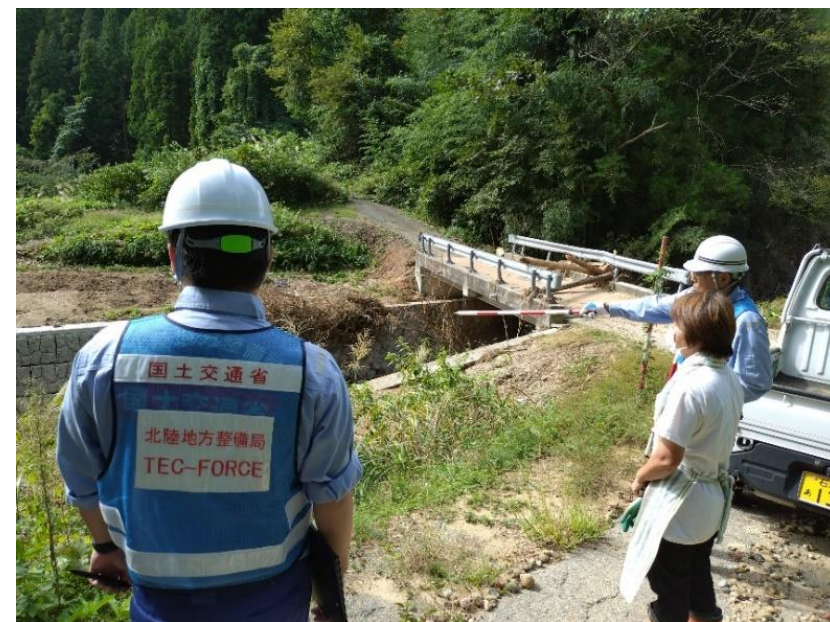
被災状況調査(能登町)
