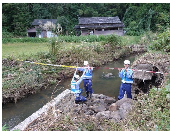
河原田川 現地調査状況
