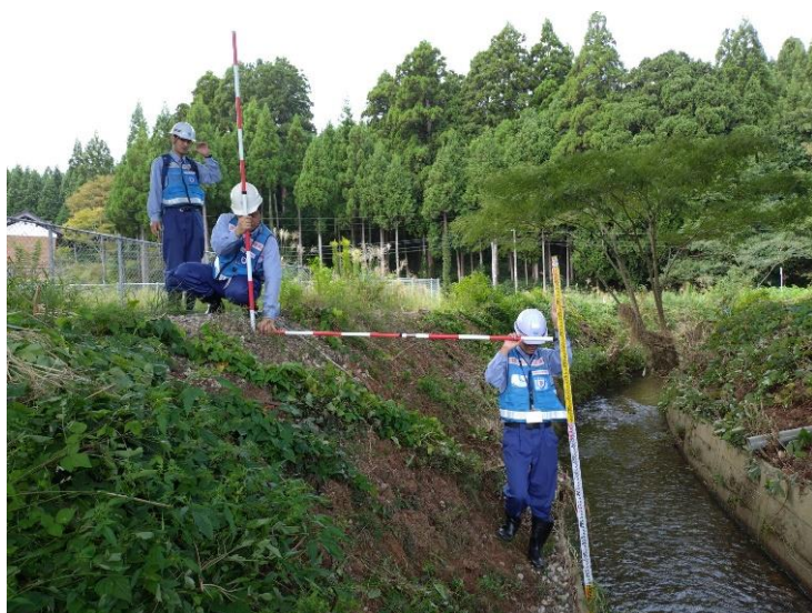
洲衛川 現地調査状況
