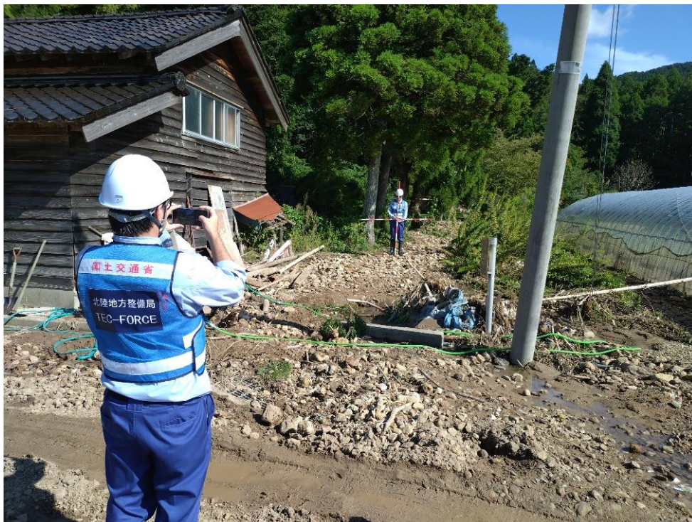
輪島市杉平町 調査状況
