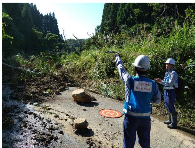
被災状況調査(極楽寺川)
