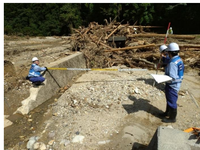
被災状況調査(清水川)
