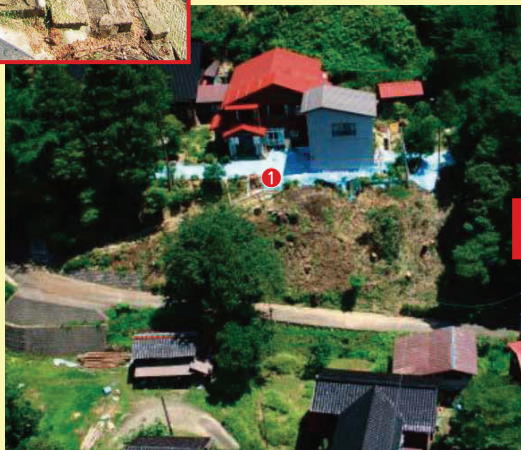
2007年7月16日の中越沖地震により発生した がけ崩れにより民家1戸が被災 (新潟県上越市柿崎区)
