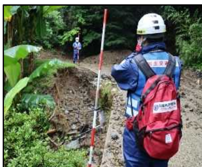
熊本県山江村 被災状況調査班（道路）
