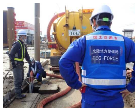
長野県長野市 応急対策(路面・側溝清掃)
