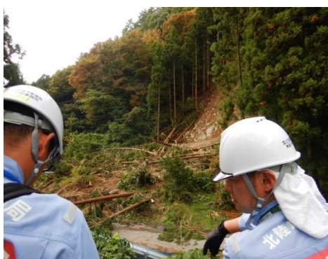
長野県長野市 被災状況調査(砂防)
