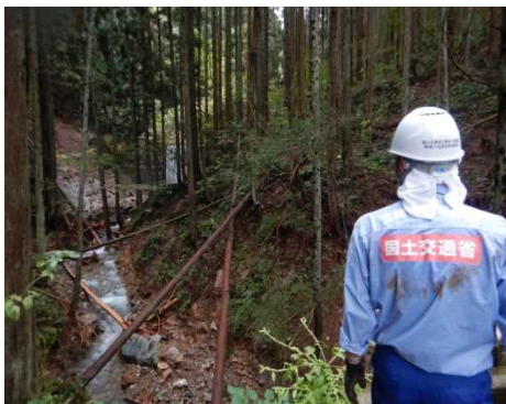
長野県長野市 被災状況調査(砂防)
