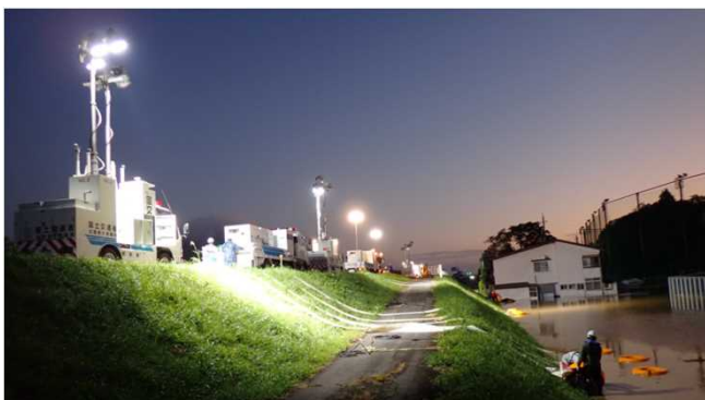
長野県飯山市 応急対策(排水)
