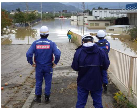
長野県長野市 応急対策(排水)
