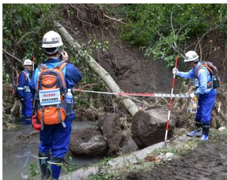
長野県小諸市 被災状況調査(河川)
