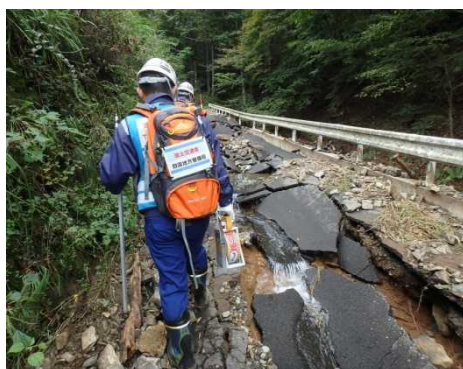
長野県南相木村 被災状況調査(河川)
