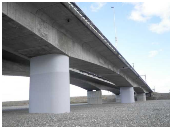
ー橋脚の補強ー
