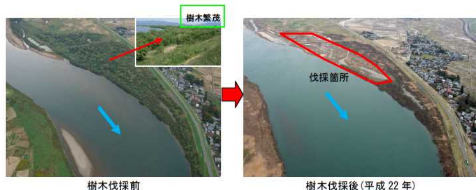
写真 4. 6-1 樹木伐採箇所の例（中新田地区、平成 21 年度伐採）
