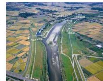
三本木大橋～善願橋付近
