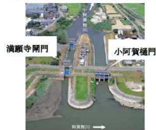
写真3.2-10 小阿賀樋門及び満願寺開門
