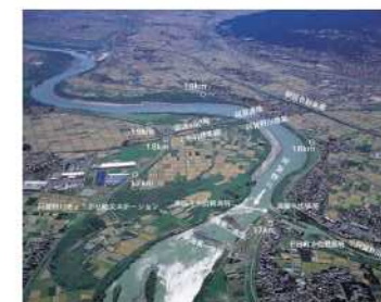
沢海床固工付近
