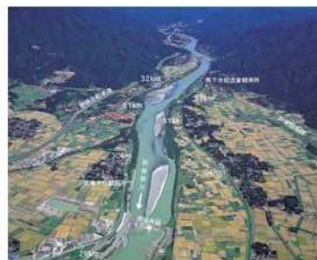
渡床床固工～馬下頭首工付近
