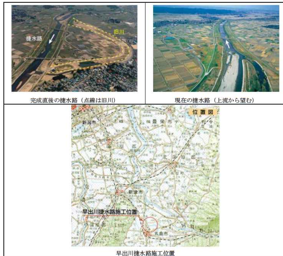
図 1.6-2 早出川捷水路の改修状況
