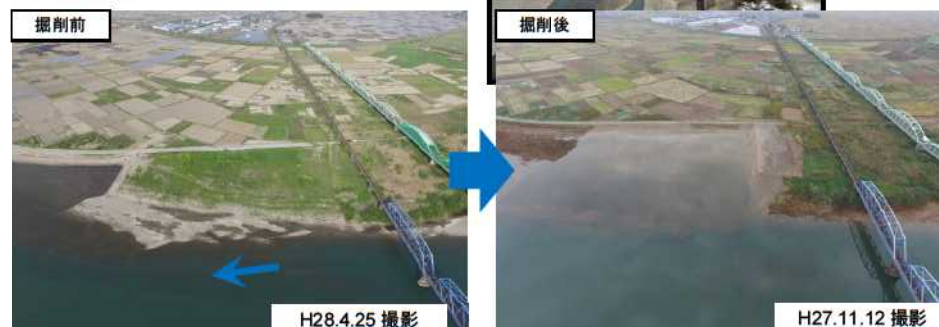
写真 4.5-1 下里地区の河道掘削状況
